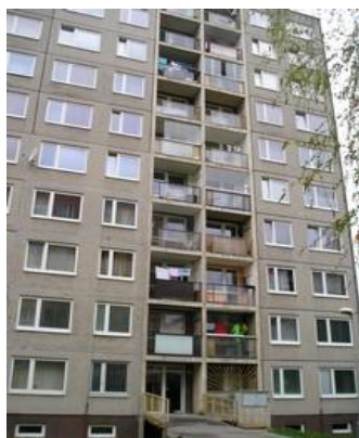
F1 Uliční pohled na budovu
